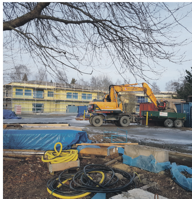
Skola Den nya Munksundsskolan med förskola växer fram.
