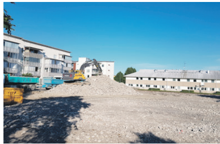
Rivning Möbelhus-tomten blir bostäder och handel.
