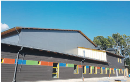
Idrott Den nya ishallen invigs 14 augusti.
