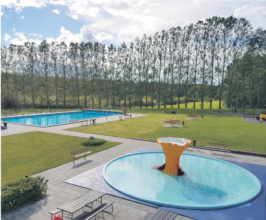
Nyrustat. Lagom till årets öppning har det 50-åriga Fjärdhundrabadet renoverats med bland annat nya uteduschar och sittgrupper, bättre gräsytor och driftsäkrare installationer.
